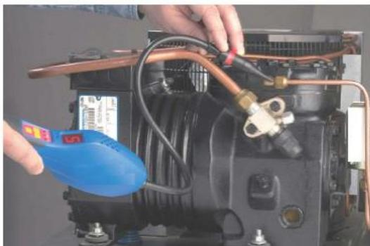
図 B.8 電子式漏えい検知器の例(3)
