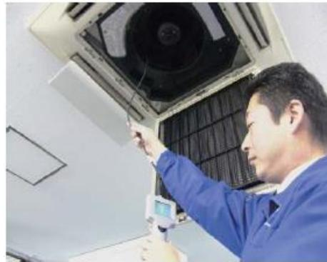
図 B.20 室内機の内部点検（例 2）
