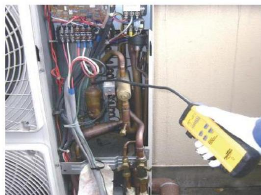
図 B.7 電子式漏えい検知器の例(2)
