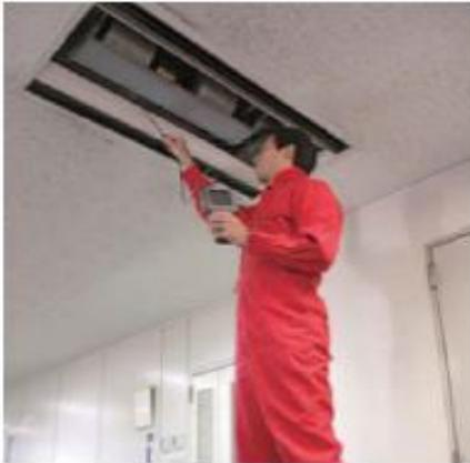
図 B.19 室内機の内部点検（例 1）
