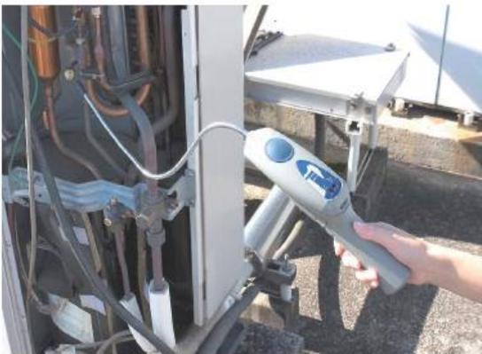
図 B.6 電子式漏えい検知器の例(1)
